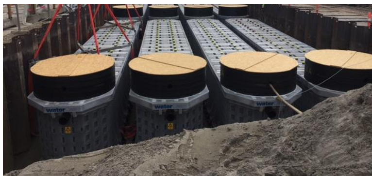
Dobbeltporøst filter til rensning af vejvand Udviklet 2001-2014
